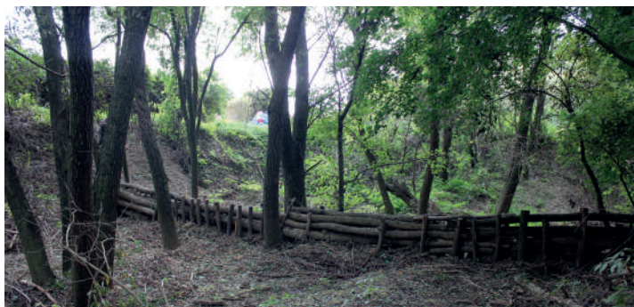
Szivárgó rönkgát Püspökszilágy egy ideiglenes vízfolyásán. Az árokban szinte soincs víz, csak heves esőzésekor telik meg, ilyenkor viszont fontos a víz és hordalék visszatartása. Hasonló eróziós árok Pilisborosjenő határában is vannak. fotó: Farkas Máttyás, WWF Mo. Alapítvány
