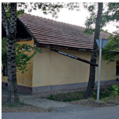
A lakosok sok helyen még úgy is a közterületre vezetik a vizet, hogy ott a csapadékvíz-elvezetés nem megoldott, ezzel aránytalan feladatot róva az önkormányzatra. Illusztrációként a sok borosjenői rossz példa helyett egy hódmezővásárhelyi esetet mutatunk be. fotó: Flickr
