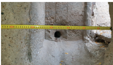
Ezen a 60 cm átmérőjű, merőlegesen elhelyezett lyukon kell átfolynia a felhőszakadás víztömegének
