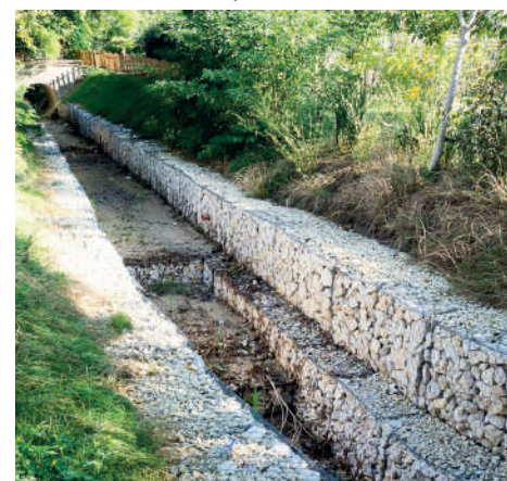
Gabionfalas mederrendezés a Budai út mentén. Költséges, és ennél jóval indokoltabb vízelvezetési, vízmérnöki munkák is lettek volna a faluban, de ehhez jól kellett volna rámutatni a valódi műszaki problémáinkra, amit egy jól szervezett műszaki bizottság a helyi szakemberek bevonásával meg is tudott volna tenni. A bökkenő az, hogy nincs műszaki bizottságunk, nincs bevonás. Érdemes lenne ezen változtatni.
