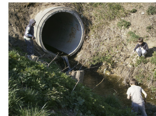
5. Az általános iskola alatti zárt csatorna-szakasz alsó csatlakozási pontja
