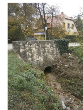
20. Kőhíd az Ilona utca csatlakozásánál
