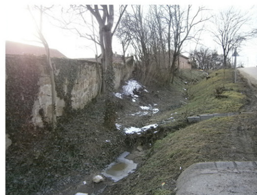
3. Csapadékvíz bevezetése, hordalékfeltöltés az első szakaszon
